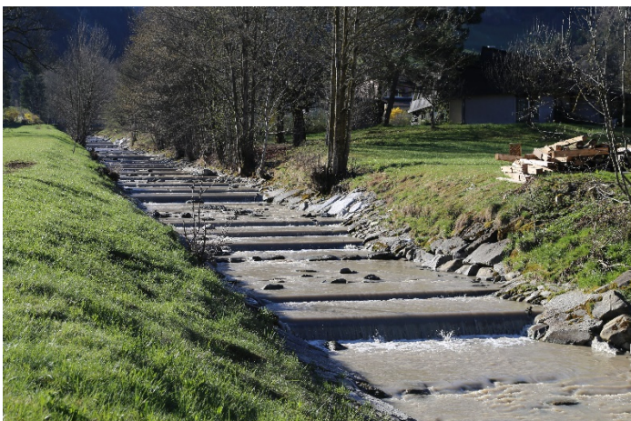
Abb. 19: Kleiner Schwellenvollverbau (Beispiel Steiglebach, Gemeinde Marbach, LU): links Foto, rechts Situationsplan. (Quellen: Kanton Luzern, DS Verkehr und Infrastruktur (vif), Abt. Naturgefahren; Bundesamt für Landestopografie swisstopo: Geoportal des Bundes)
