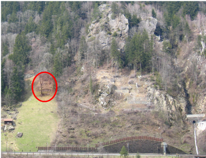
Abb. 20: Hangstützbauwerke der SBB aus der Zeit um 1900: links als Werksgruppe, rechts Einzelbauwerk. (Quelle: SBB AB, Ingenieurbau und Umwelt, Natur und Naturrisiken)
