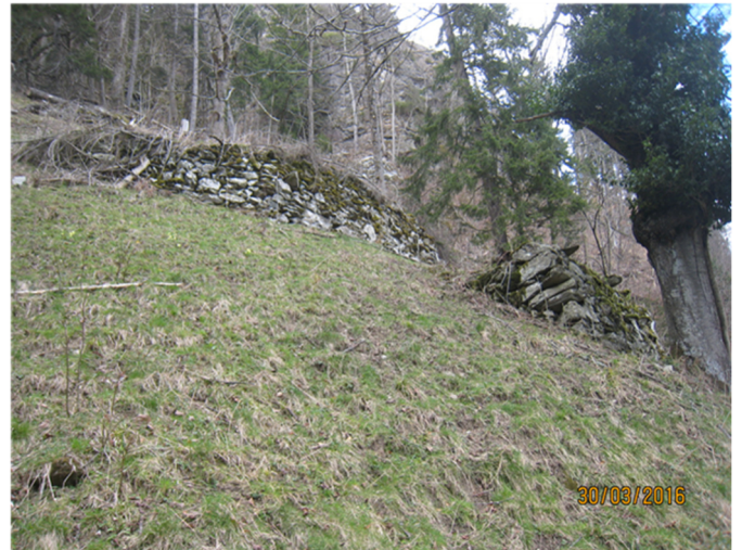
Abb. 20: Hangstützbauwerke der SBB aus der Zeit um 1900: links als Werksgruppe, rechts Einzelbauwerk. (Quelle: SBB AB, Ingenieurbau und Umwelt, Natur und Naturrisiken)
